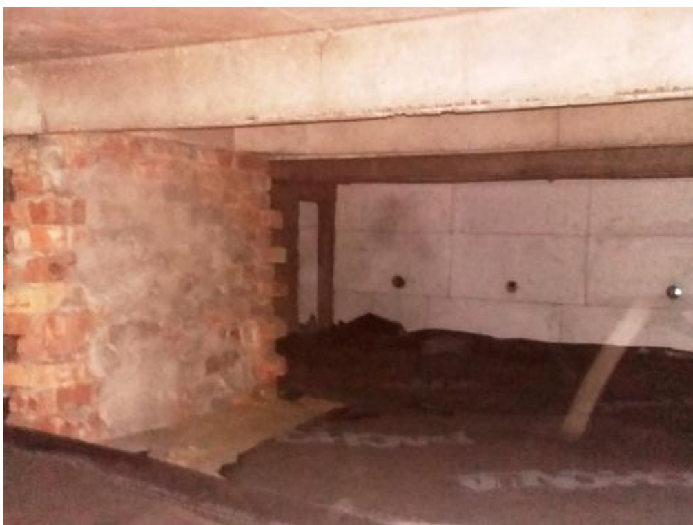
Konstrukcja poddasza - budynki przy ul. Le Ronda 16d -16f
