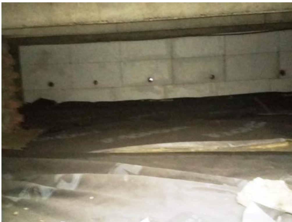
Konstrukcja poddasza - budynki przy ul. Strzelców Bytomskich 21a - 21e
