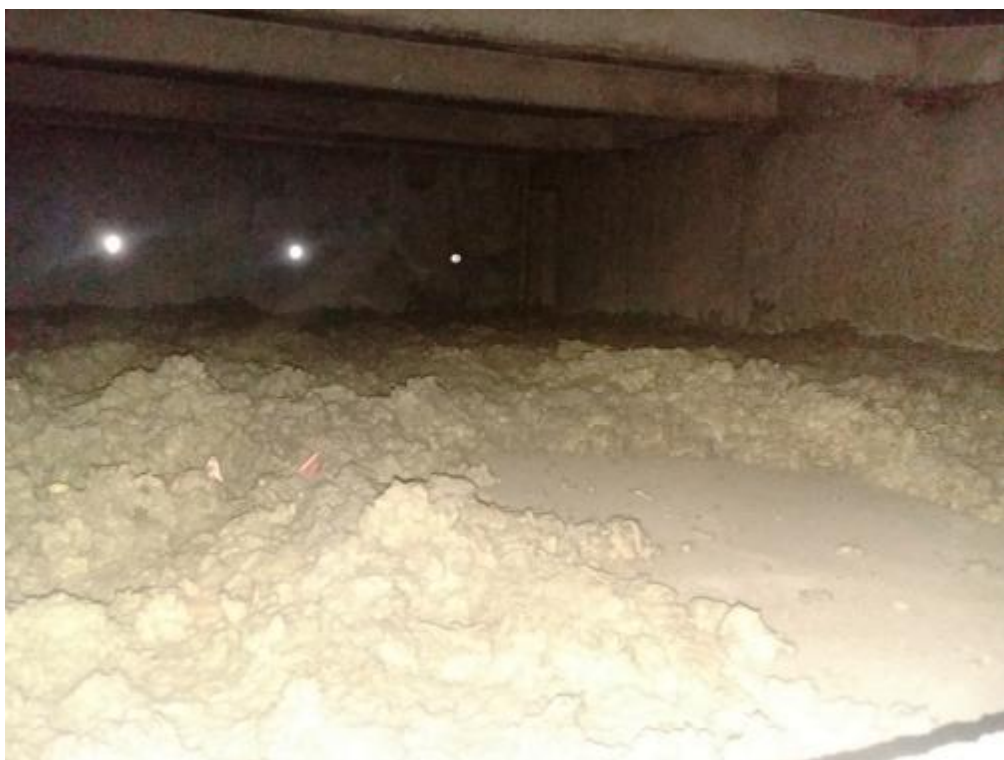
Konstrukcja poddasza - budynki przy ul. Grzegorzka 18a - 18d
