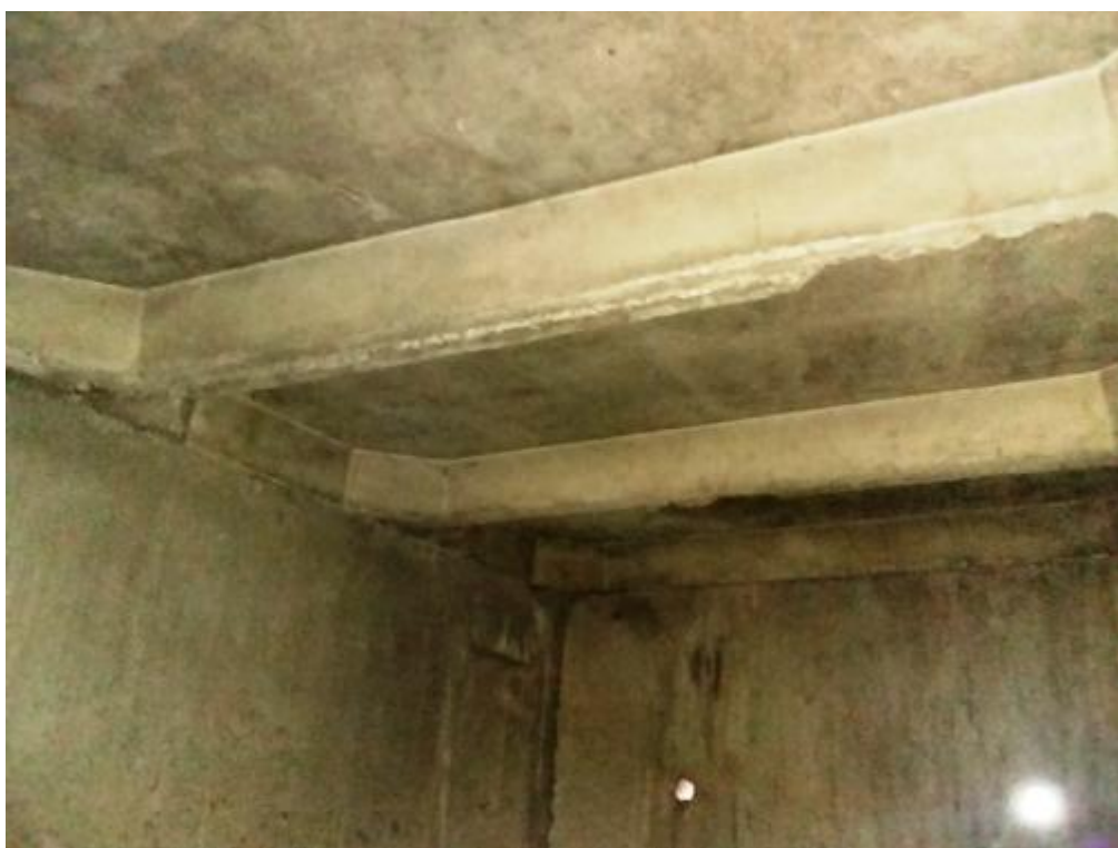
Konstrukcja poddasza - budynki przy ul. Grzegorzka 14a - 14d
